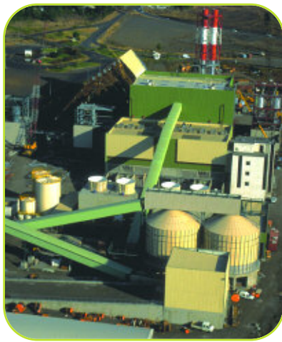
Centrale à charbon et bagasse du Gol, sur l'île de la Réunion.
